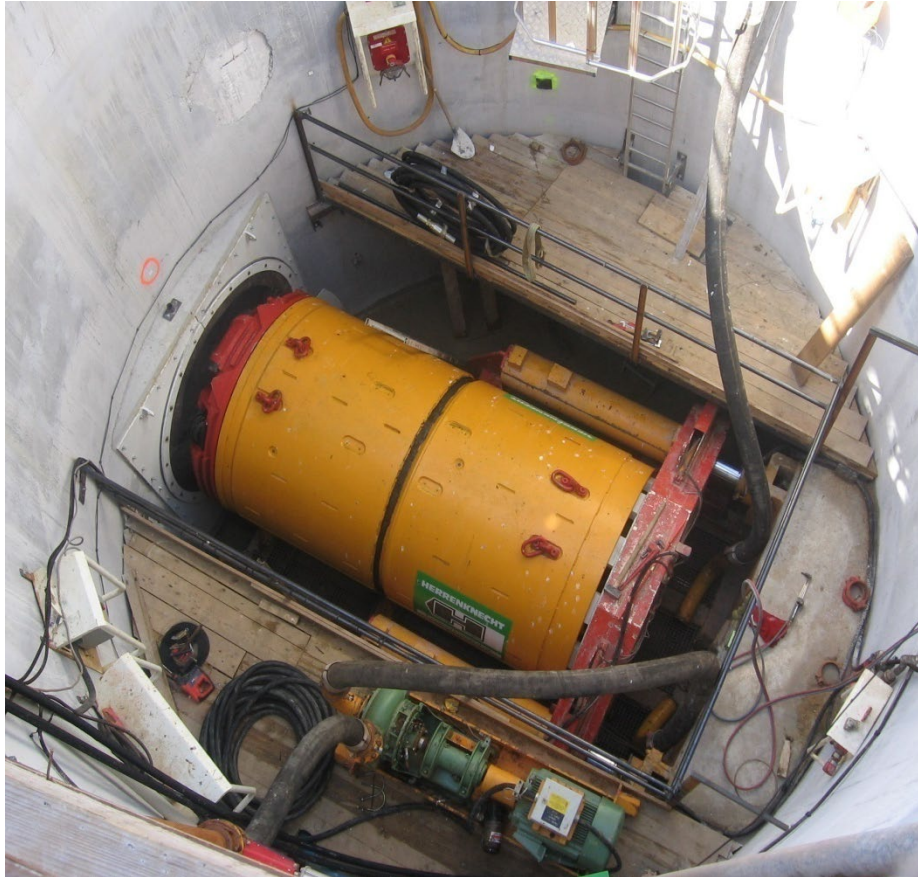
Pozo de Lanzamiento
