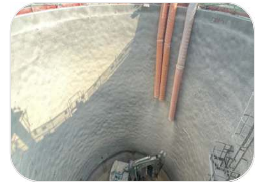
CONCRETO LANZADO Y MALLAZO
