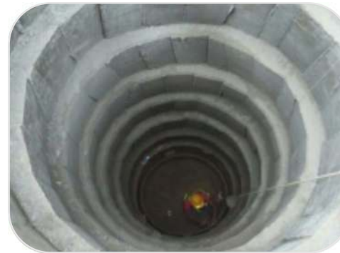
CAISSONS DE CONCRETO
