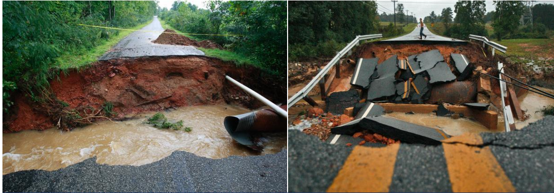
Atlanta, GA Tuberías de aguas pluviales
