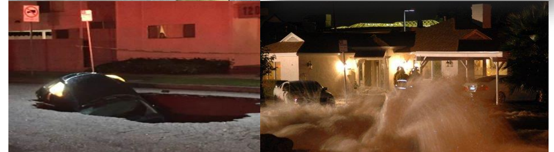
Los Angeles, CA Acueductos de 6" y 64" de 1.5 m
