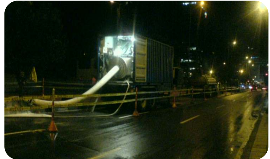
vs Tecnología sin zanja
