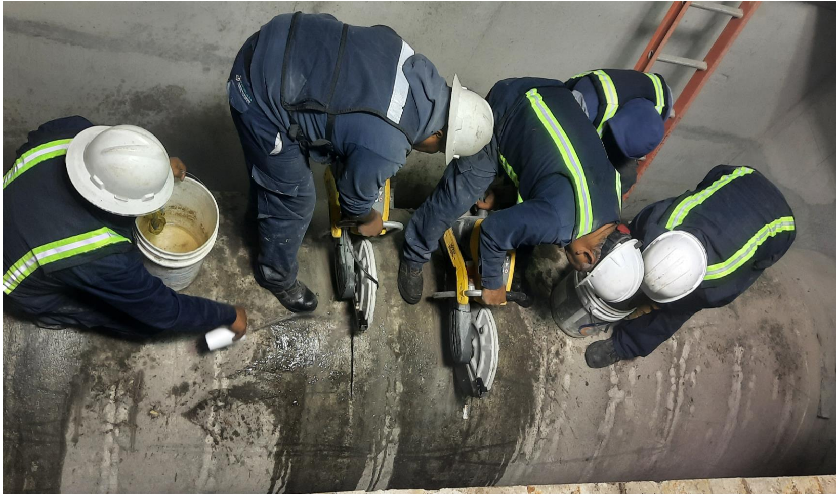
CORTE Y RETIRO DE TUBERÍA EXISTENTE
