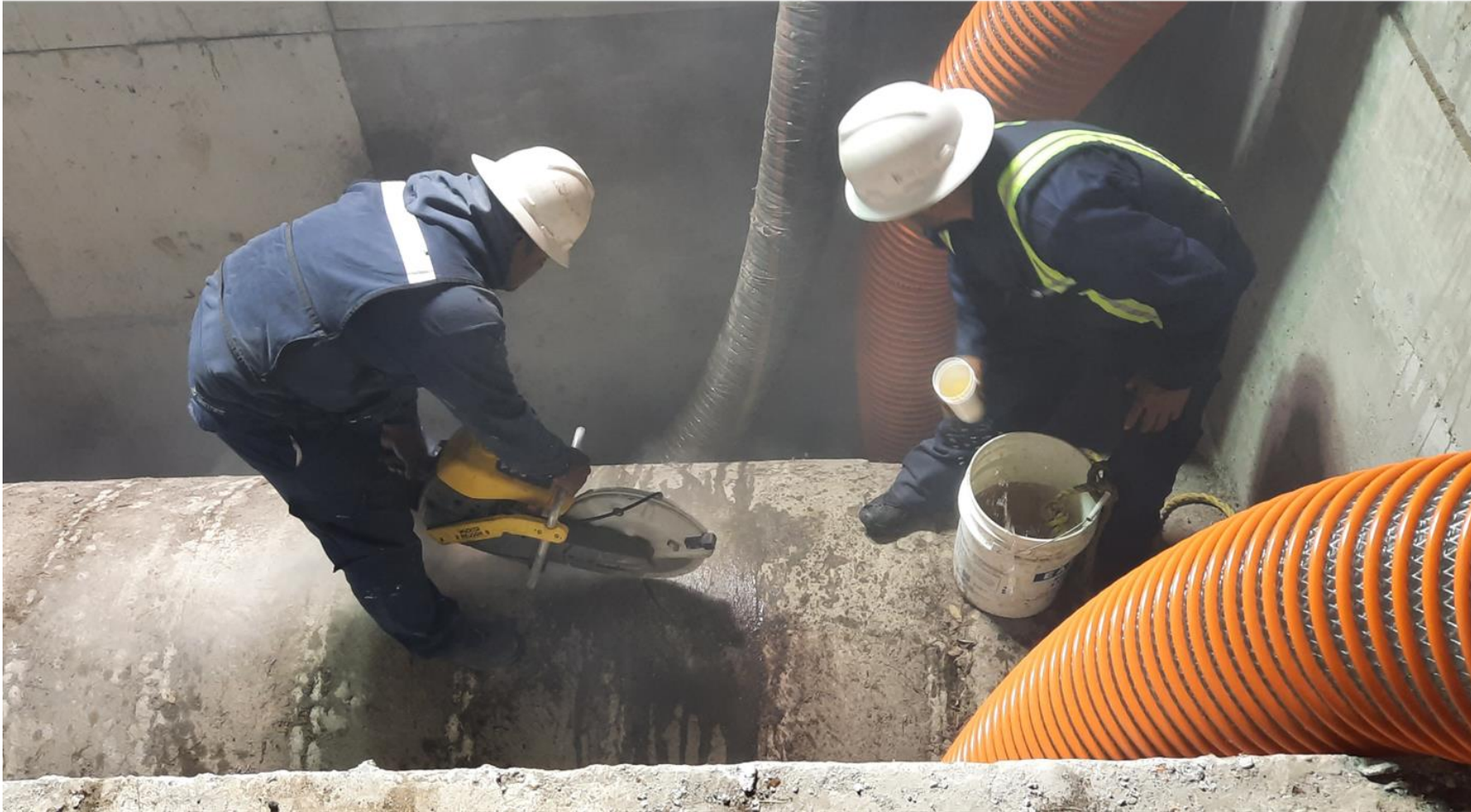
CORTE Y RETIRO DE TUBERÍA EXISTENTE
