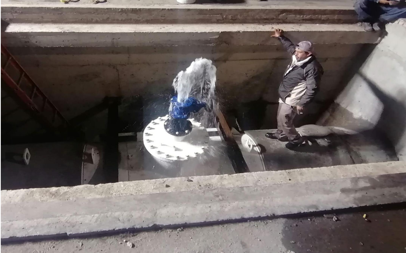
COLOCACIÓN DE VÁLVULAS Y PRUEBAS FINALES
