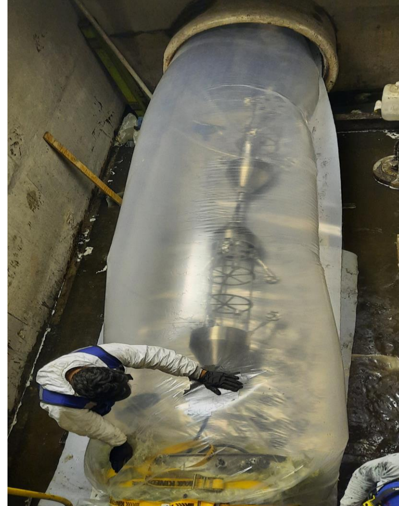
COLOCACIÓN DE TREN DE LUCES PARA CURADO
