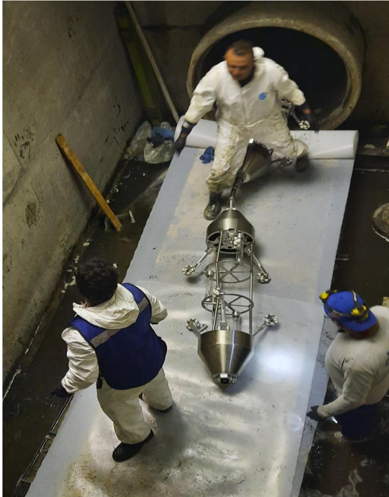
COLOCACIÓN DE TREN DE LUCES PARA CURADO
