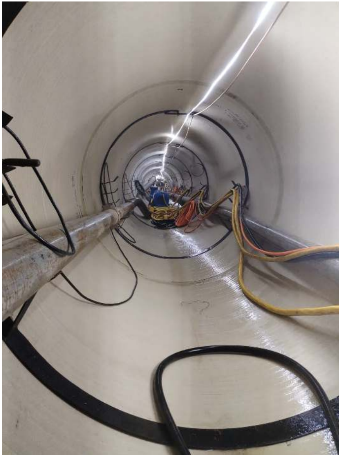
Soportes internos para cables y ductos
