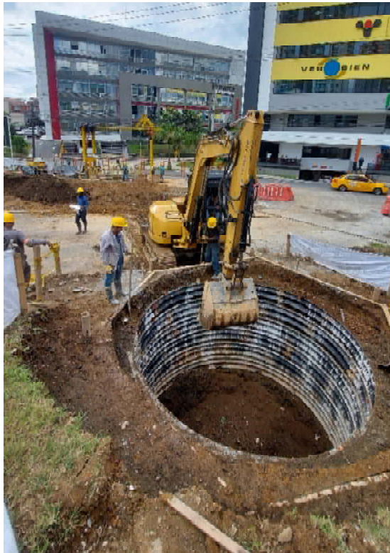
Excavaciones de pozos
