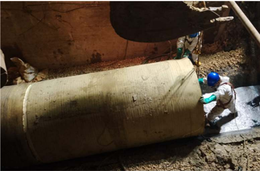
Posicionamiento de tubería y estructura para empuje
