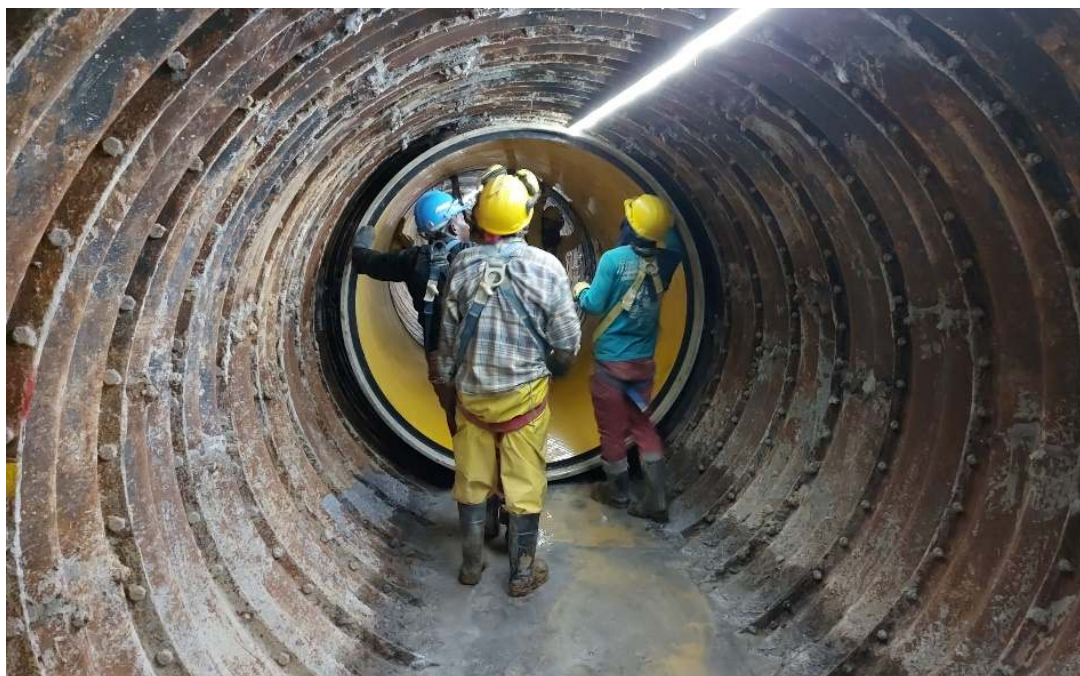
Ingreso de tubería en túnel
