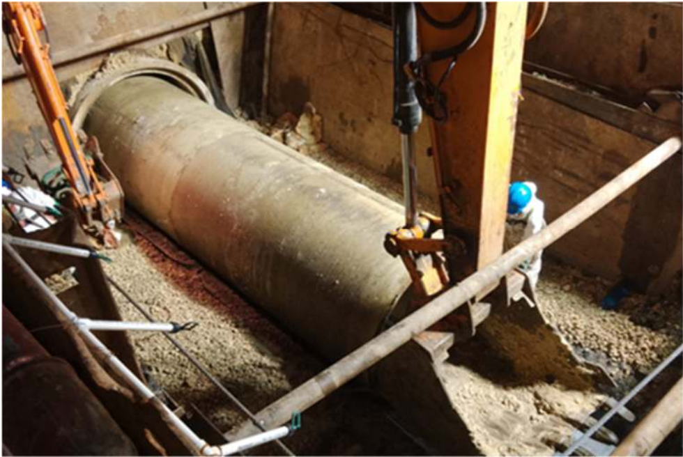
Empuje de tubería con maquinaria
