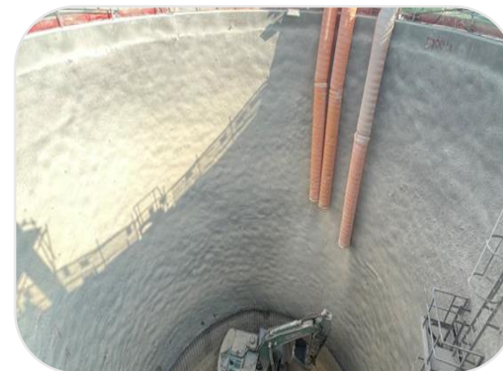
CONCRETO LANZADO Y MALLAZO
