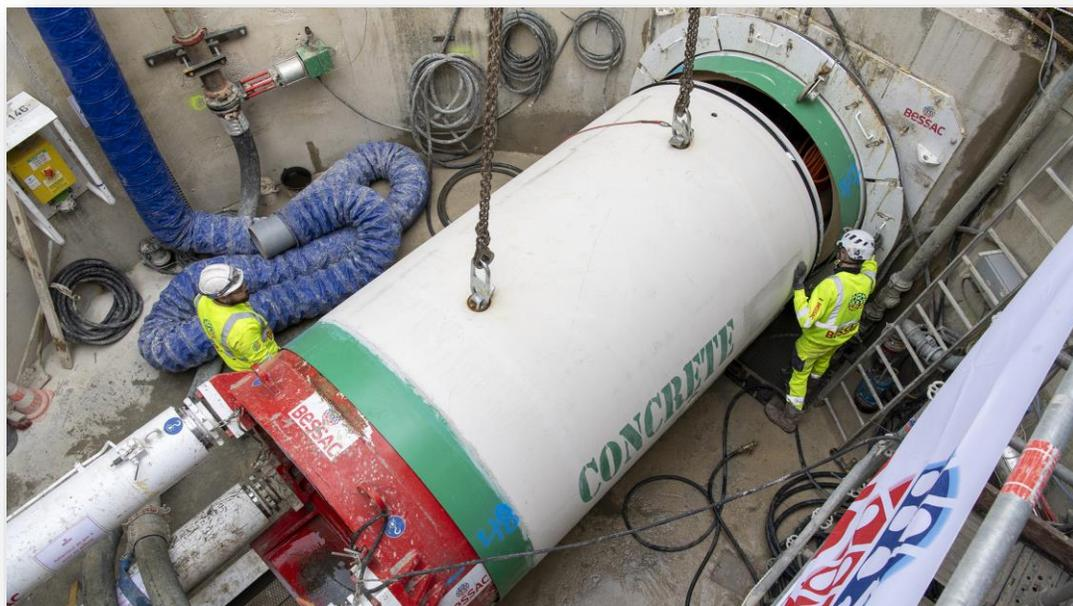
Fórmula de concreto **cuatro** veces más baja de CO<sub>2</sub> que las utilizadas generalmente para tuberías de hincapi prefabricadas. (**84 kg CO<sub>2</sub>-eq/m<sup>3</sup>**)
