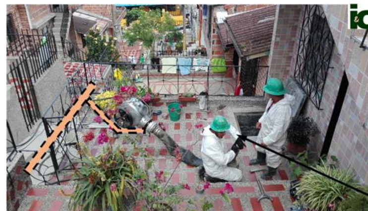
Acometida 6" alcantarillado con curva → CIPP esp=3mm
