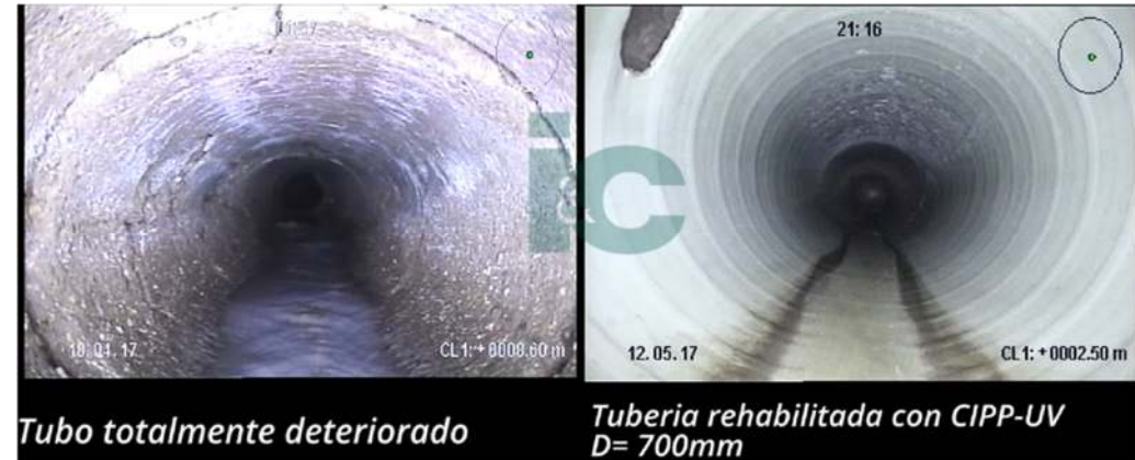
Antes y después de Rehabilitar Proyecto Centro Parrilla, IYC
