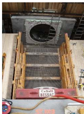
Portal de Ingreso
