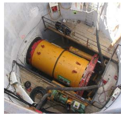
Instalación a fondo de pozo
