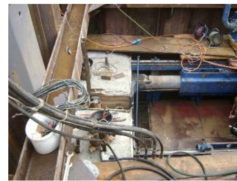
Muro de reacción
