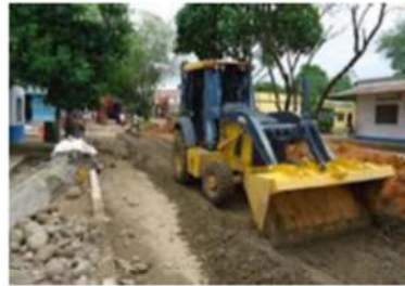
Actividad Zanja abierta
