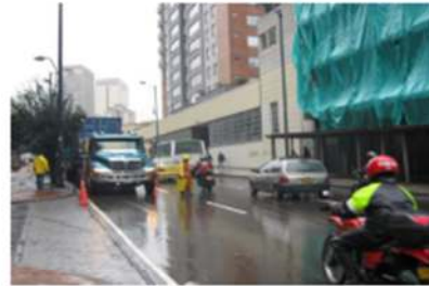
Actividad Sin Zanja
