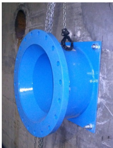
Conector con placa para montaje sobre muro (1)
