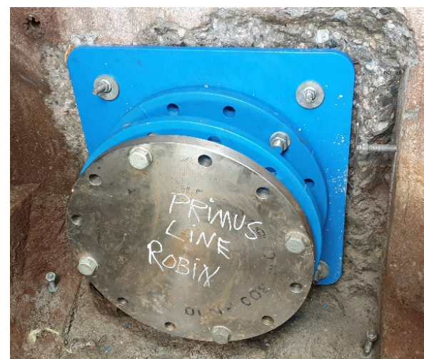
Conector con placa para montaje sobre muro (2)
