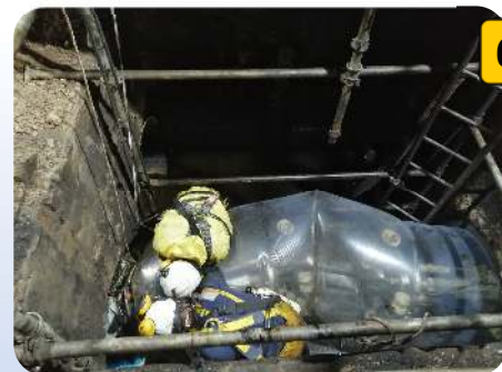
Instalación de Equipos
