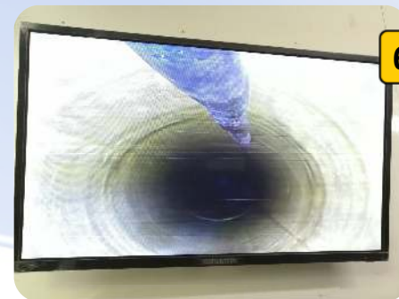
Curado de Liner
