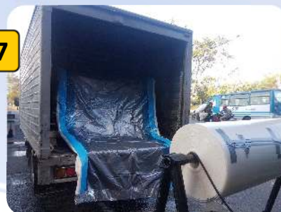
Instalación Liner y equipos Horario: 2:00pm a 10:00 pm
