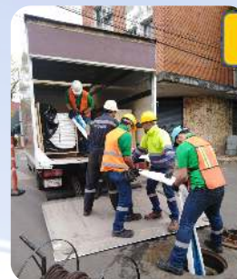
Instalación Liner Horario: 2:00pm a 10:00 pm
