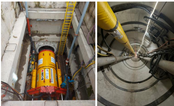
AVN1600 en pozo de lanzamiento y túnel para suministro de agua finalizado en Bogotá (Colombia)
