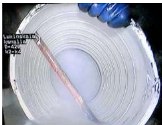
Figura 6. Proceso de bloqueo con barra para inicio de expansión. ISTT. (2013).
