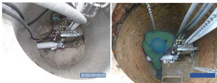
Figura 5. Máquina de bobinado en pozo de inspección Inicial. Fuente: Propia
