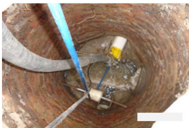
Figura 10. Montaje de válvula e inyección de aire. Fuente: propia
