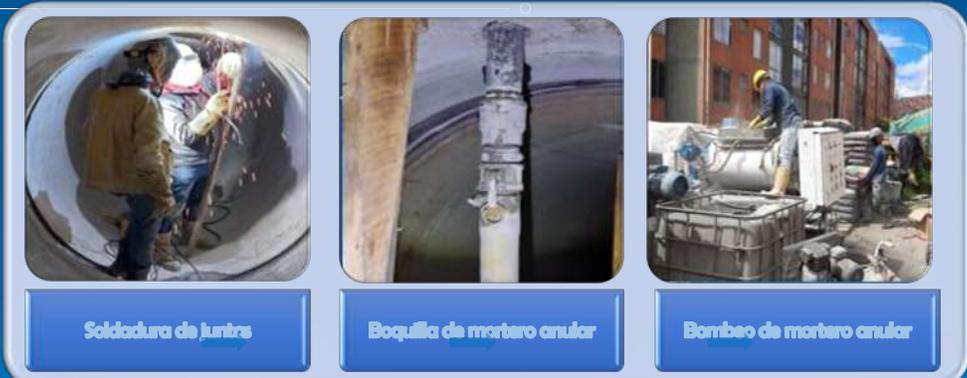
**Soldadura de junta**      **Boquilla de mortero anular**      **Bombeo de mortero anular**
