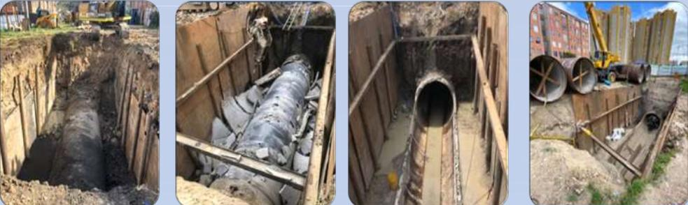
Excavación → Demolición mortero exterior → Corte y retiro parte superior de la tubería → Ubicación de grúa para trazo de camisa de acero
