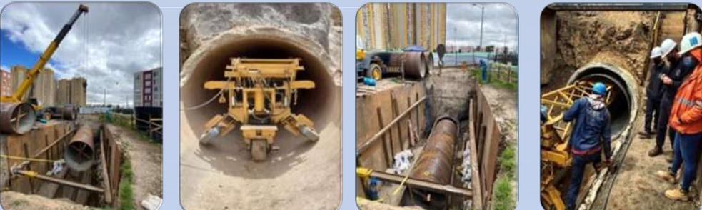
Lazo camisa de acero (Ø= 12 mm con mortero interior centrifugado de 4000 psi) → Carro para transporte de camisa de acero → Posicionamiento carro de acero → Transporte interno camisa de acero
