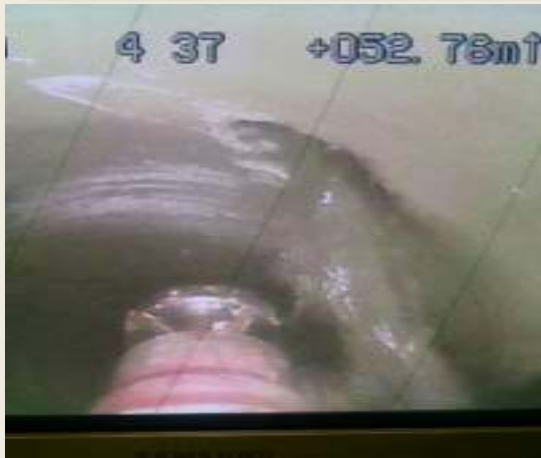
Apertura de la conexión de las domiciliarias
