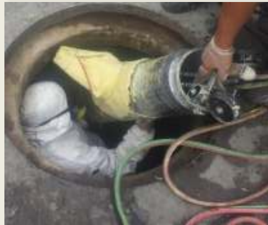
Reparación de la conexión de las domiciliarias
