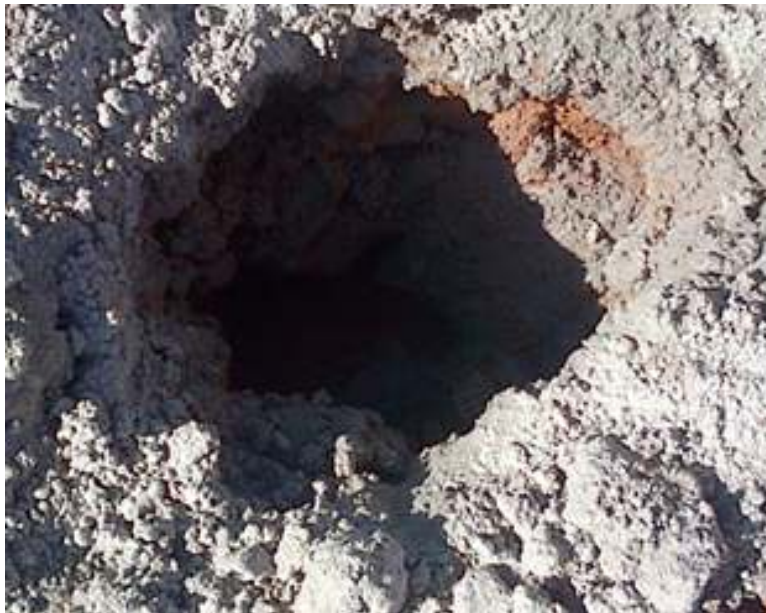
Sin aditivos de perforación
