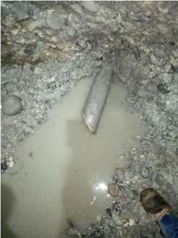
Recepcion del pilotaje en pozo de recepcion
