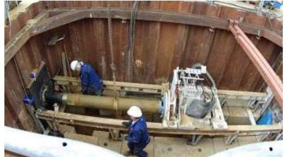
Recepcion de tuberia plastica en pozo de lanzamiento
