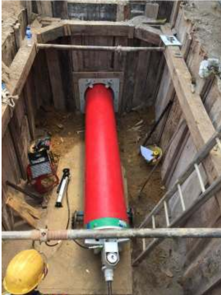
Inicio de jalado de tuberia plastica en pozo de recepcion
