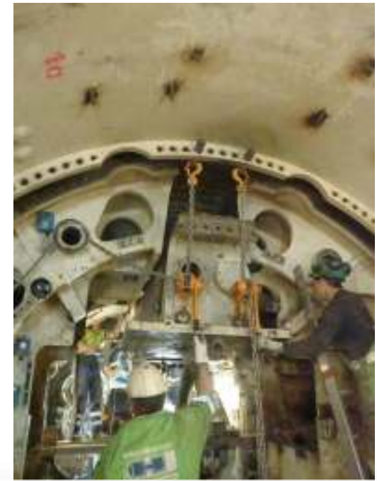
▶ Diseño de la máquina para el desmontaje dentro del túnel sin caverna, posible reutilización de la máquina.
