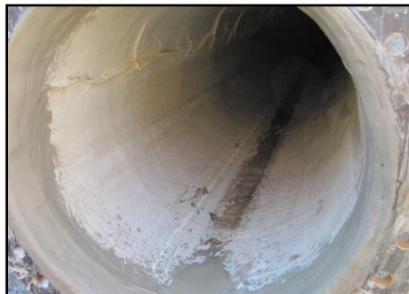
Foto 4. Unión de la tubería con el pozo de inspección.
