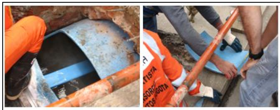
Foto 5. Extracción de muestra CIPP.
