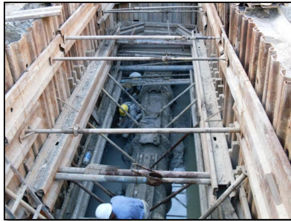
Foto 1. Construcción de alcantarillados con zanja abierta.
