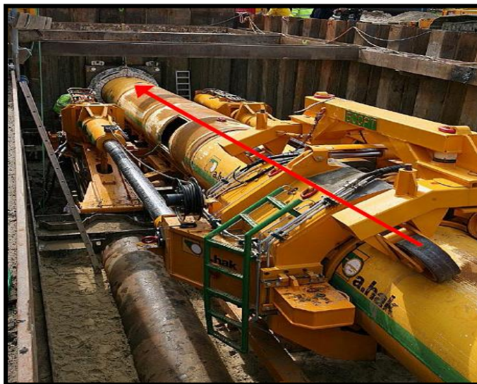
Foto 22 Máquina de empuje penetrando la tubería nueva Herrenknecht 2011
