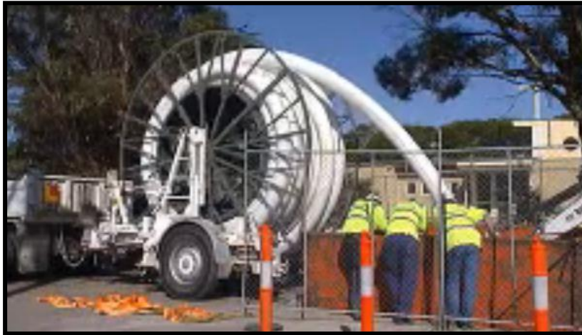
Foto 31 Instalación de la tubería de polietileno Compact pipe Utility services 2011
