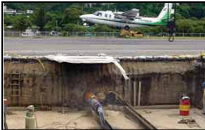
Foto 16 Hincado de camisas de acero bajo pista de aviación Hammerhead 2011
