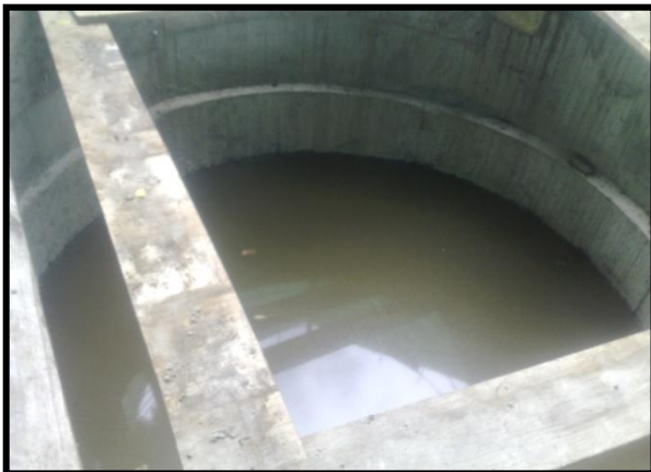
Foto 83 Pozo de salida de la máquina excavadora AVN.
