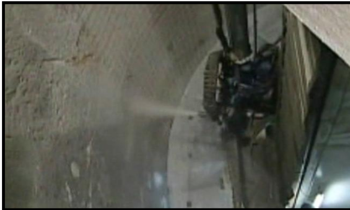
Foto 11 Robot en el proceso de lanzado de concreto Herrenknecht 2011
