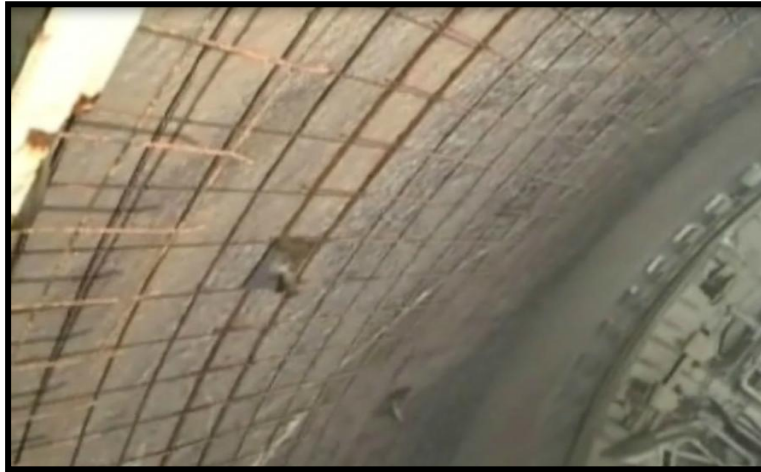
Foto 12 Mallas de acero instaladas en las paredes del túnel Herrenknecht 2011
