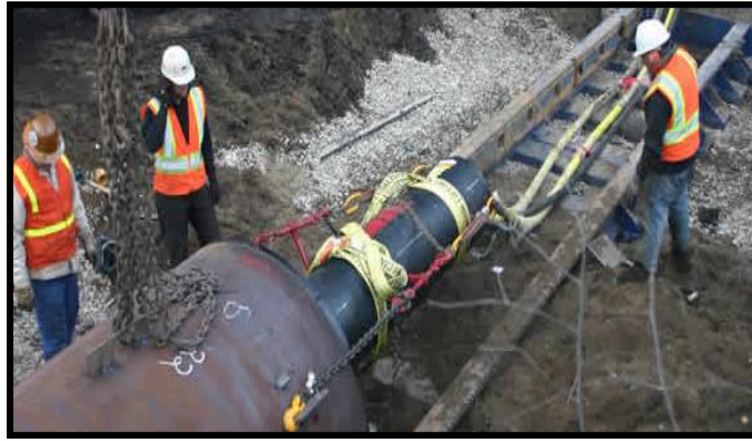
Foto 15 Adecuación en obra del proceso de hincado horizontal de camisas de acero Hammerhead 2011
