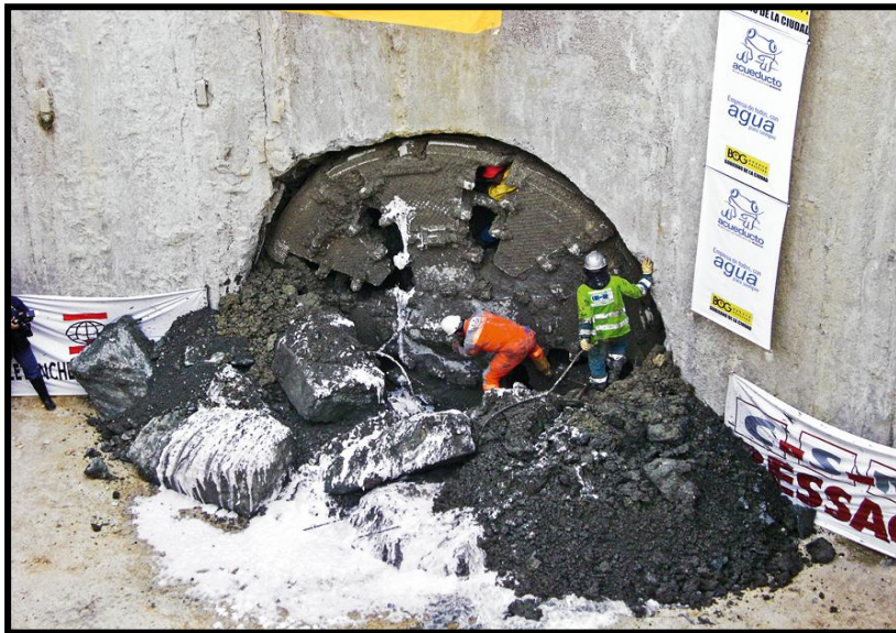
Foto 3: Llegada de TBM a pozo interceptor Tunjuelo bajo Titán 2011
