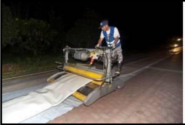
Foto 67 Proceso de impregnación Pavco, 2011 Foto 68 Unidad de Reversado y Curado Pavco, 2011
