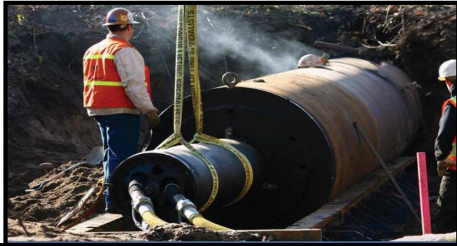
Foto 60 Martillo neumático Hammerhead, 2011 Foto 61 Instalación de la tubería Hammerhead, 2011
