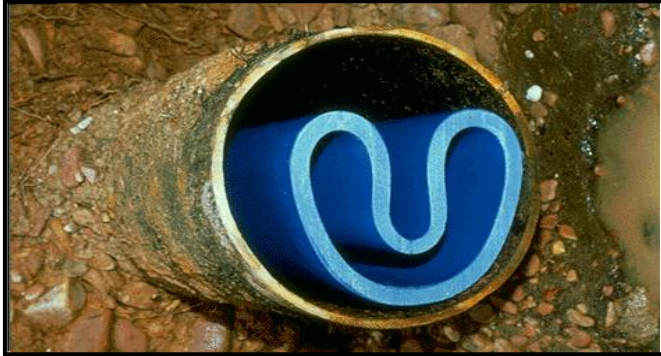
Foto 69 Tubo de Polietileno en forma de U (Vidal, 2011)
