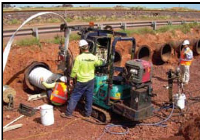
Foto 36 Proceso de renovación usando la tecnología expanda Interflow, 2011
