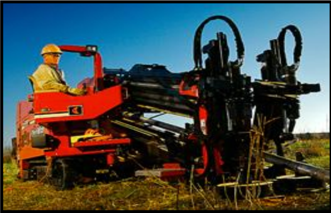
Foto 57 Máquina HDD. Tecmece, 2011
