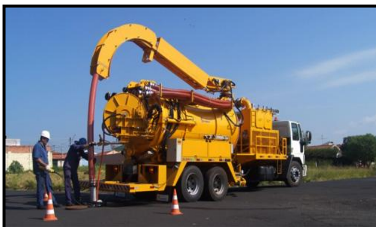
Foto 24 Camión para limpieza de tubería VE-Tecnologías sin zanja 2011
