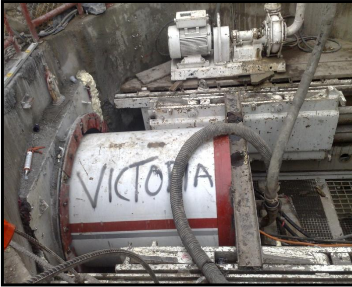
Foto 87 Máquina tuneladora en proceso de perforación Foto 88 Grúa para los prefabricados
