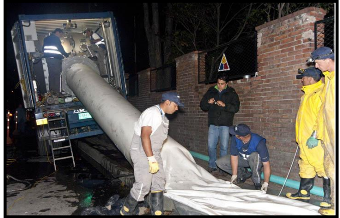
Foto 67 Proceso de impregnación Pavco, 2011 Foto 68 Unidad de Reversado y Curado Pavco, 2011
