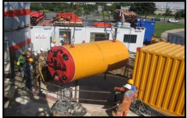
Foto 51 Montaje de la tuneladora AVN Bessac, 2011
