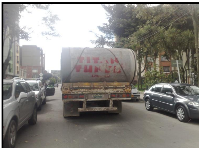
Foto 86 Camión con tubería lista para instalar.
