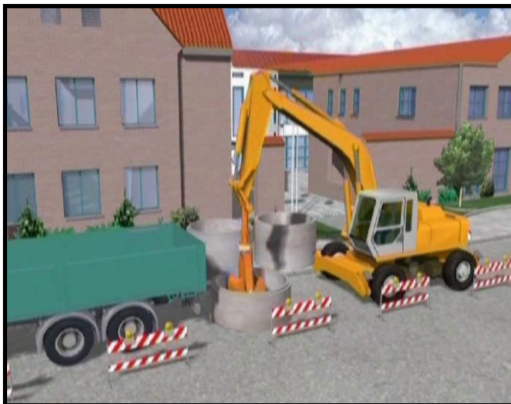
Foto 18 Construcción del Manhole Bohrtec 2011
