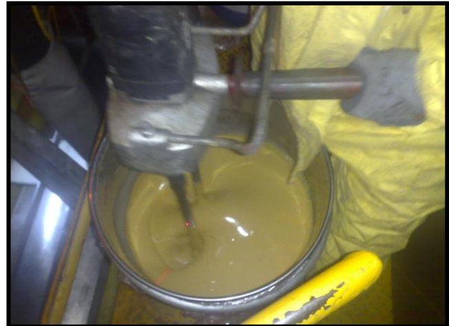
Foto 96: Procedo de vertido de la resina
