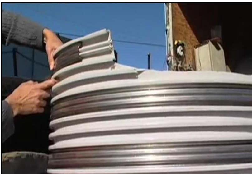
Foto 38 Tiras de Pvc y Acero utilizadas en el método Ribline MDCCCLI, 2011
