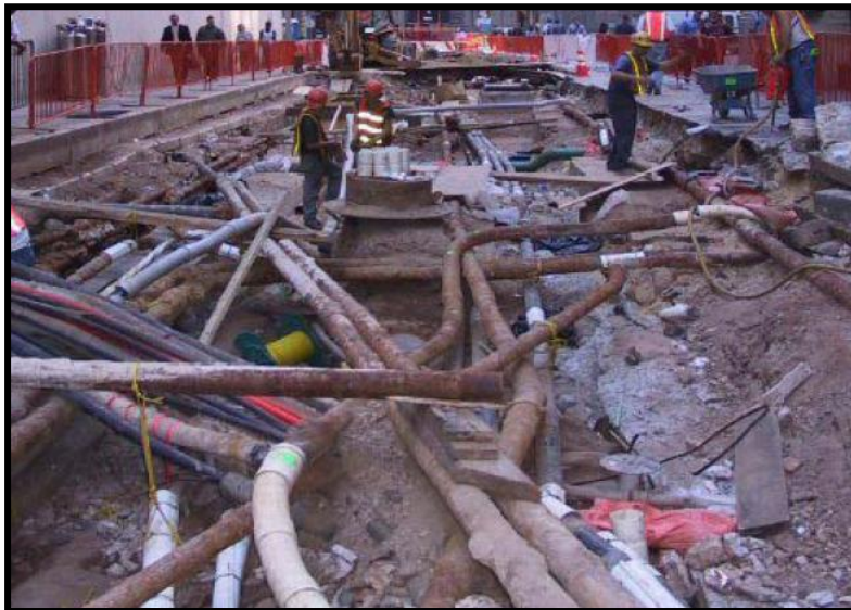
Foto 1: Distribución de redes de servicios públicos de todo tipo, e impacto social que se deriva de la excavación a cielo abierto. ISTT 2011
