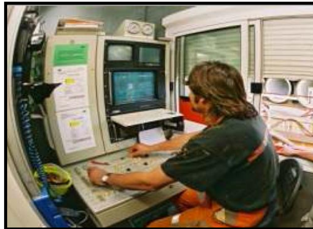
Foto 2: Cabina de operación de la máquina TBM Bessac 2011.
