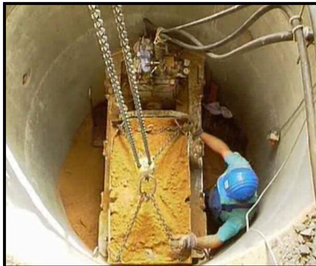
Foto 20 Vagón lleno con material listo para ser retirado por el sistema de grúas Bohrtec 2011
