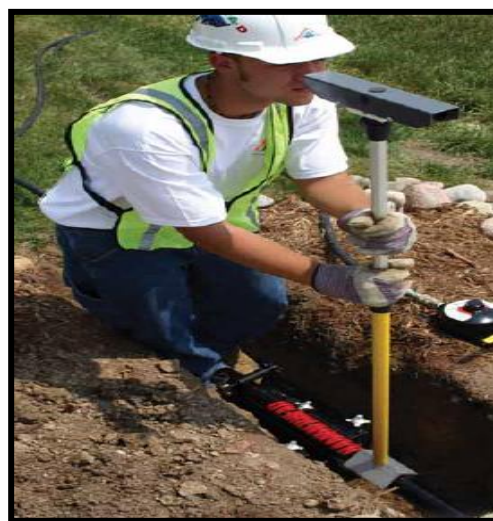
Foto 14 proceso de perforación y guiado a través del topo neumático Hammerhead 2011
