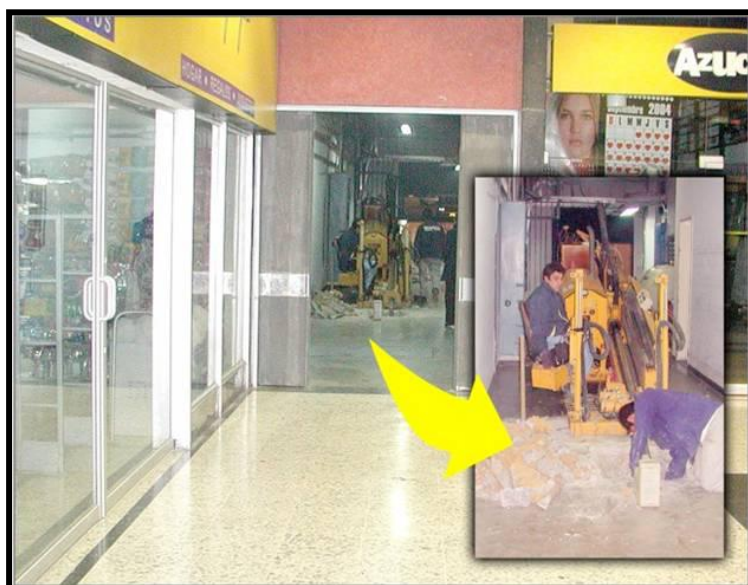
Foto 97 Trabajos con PHD en un centro comercial de Bogotá. Treltec, 2011
