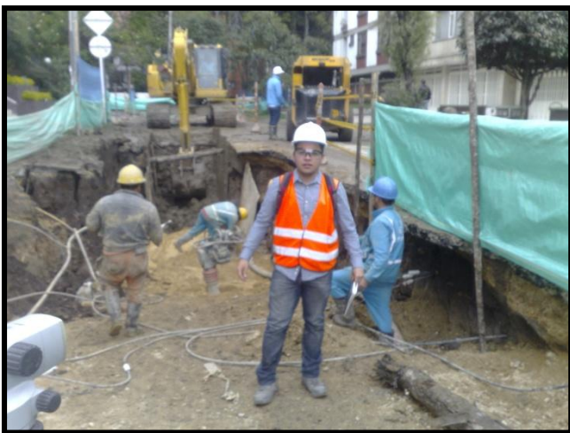
Foto 81 Frente de obra con Tecnología a zanja abierta
