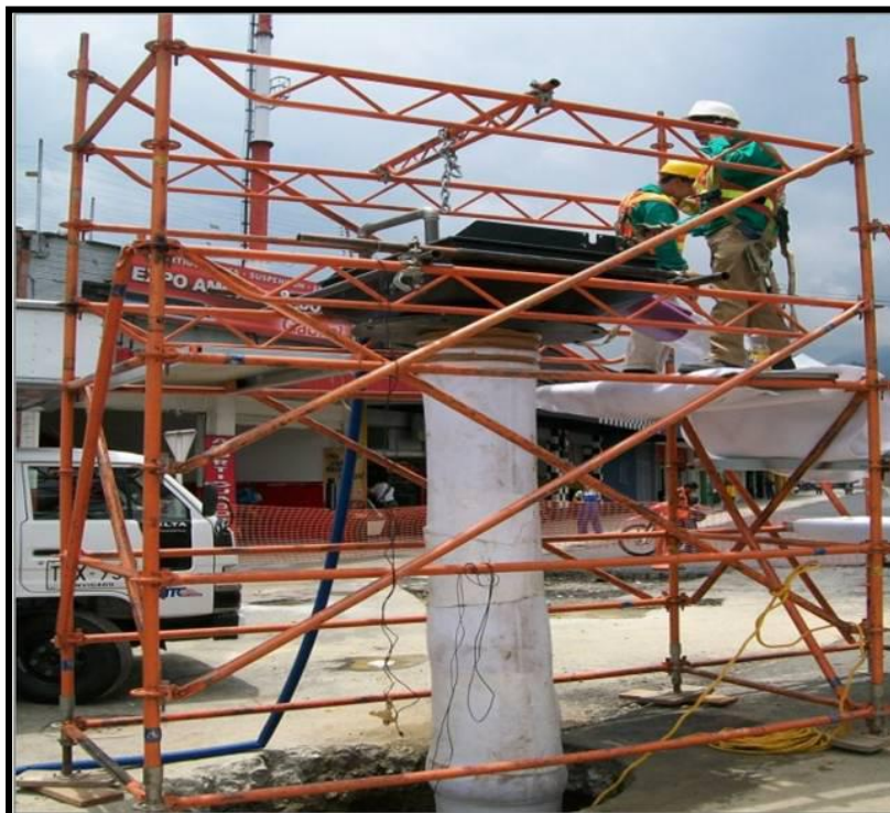
Foto 103 Torre de ensamble para el proyecto “Avenida 33” EPM, 2011
