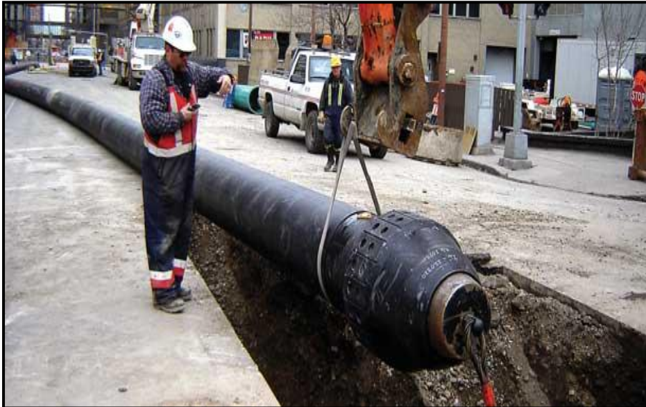
Foto 42 Sistema Pipe Bursting neumático Hammerhead, 2011
