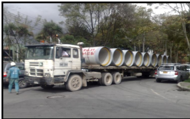
Foto 85 Camión con tubería lista para instalar
