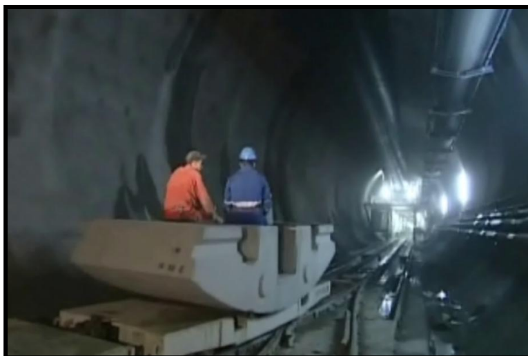
Foto 9 Transporte de dovelas a través de los rieles Herrenknecht 2011
