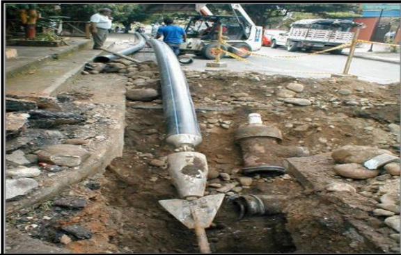
Foto 79 Halado de la tubería nueva (EPM, 2011)
