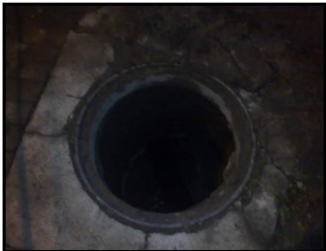
Foto 91 Manhole de entrada
