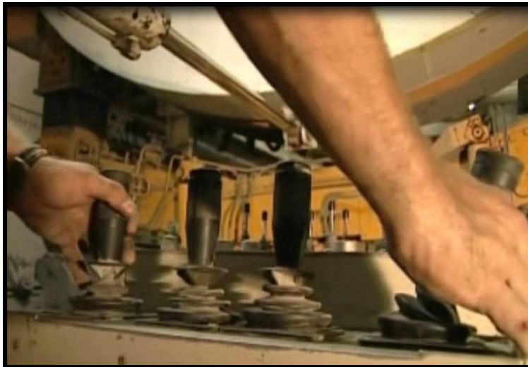
Foto 10 Operación de la cabina de mando para la instalación de las dovelas Herrenknecht 2011
