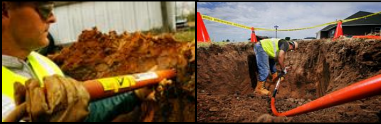
Foto 59 Topos neumáticos trabajando Tecmecco, 2011
