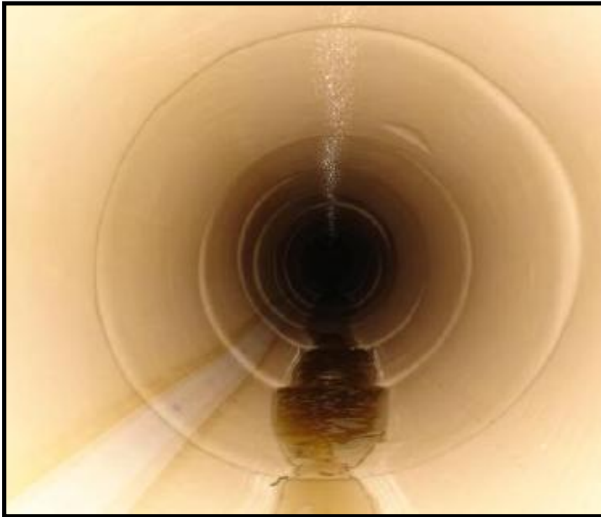
Foto 101 Estado final de la tubería de la CII 106 después de intervenir (Pavco, 2011)
