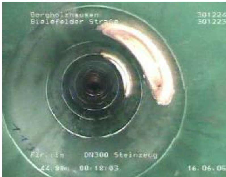
Ilustración 7. Tubería totalmente sometida a Proceso Janssen. (S.A., 2012)
