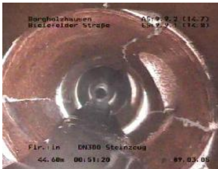
Ilustración 6. Tubería parcialmente sometida a Proceso Janssen. (S.A., 2012)
