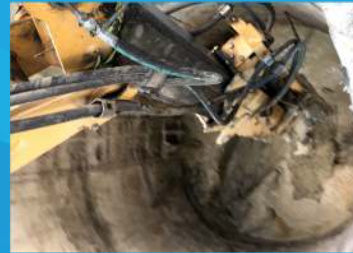
Vista pozo de recepción
