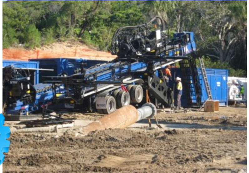
Equipos de Perforación Direccional y herramientas
