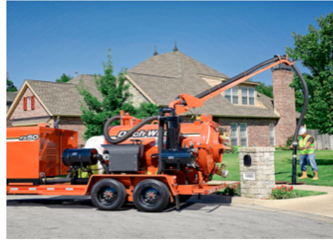
Excavación al vacío
