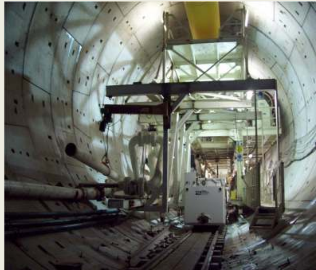
Sistema de rezaga de material por medio de bombeo.
