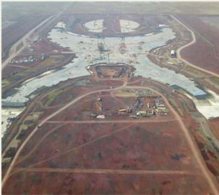
Loza de Cimentación de Terminal Área / Pistas 2 y 3
