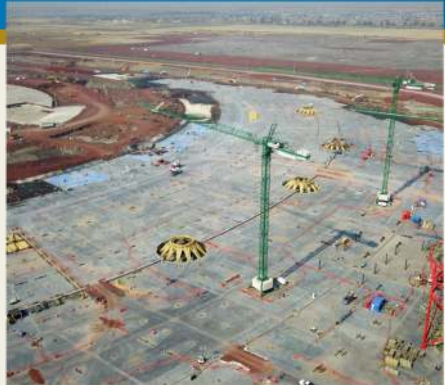
Loza de Cimentación de Terminal Área / Pistas 2 y 3
