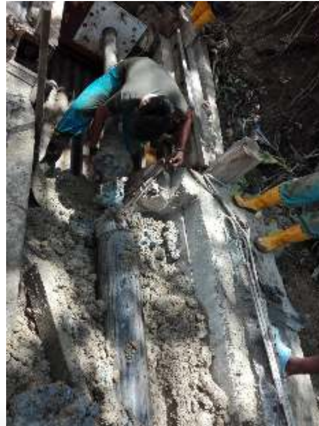
Recepcion de tuberia de PEAD de 10" en pozo de lanzamiento
