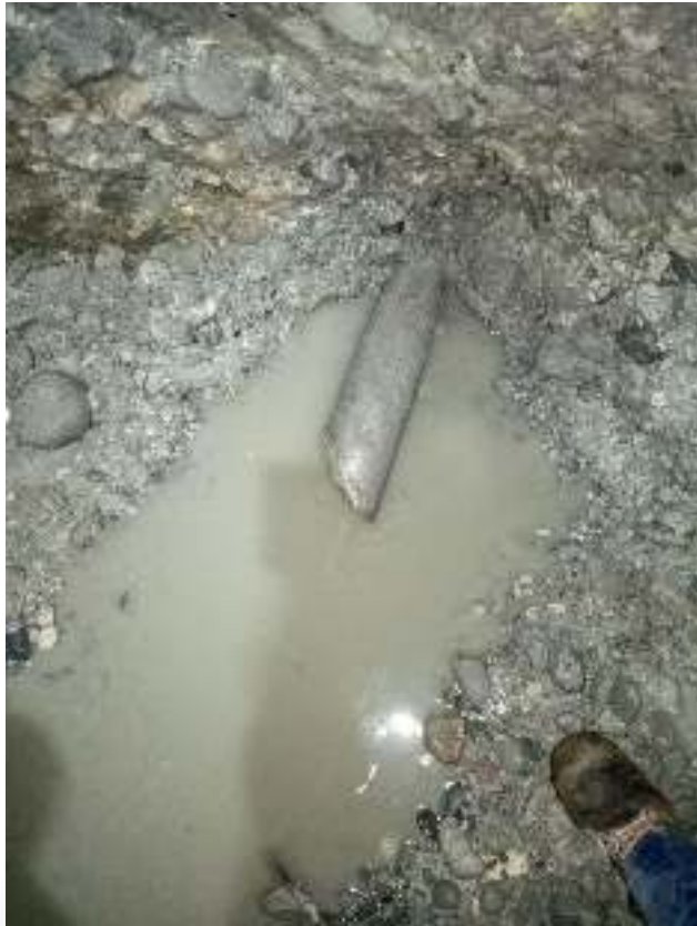
Recepcion del pilotaje en pozo de recepcion
