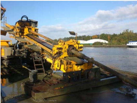
Fig. 17. Grobbendonk – Drilling rig 1000 kN
