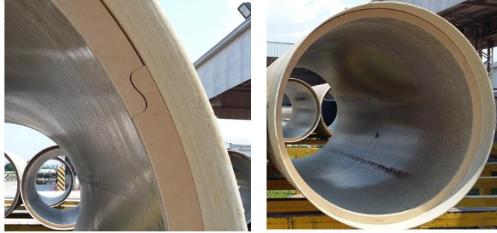
Figura 9. Detalle de los anillos de madera en el espigo para distribución de esfuerzos
