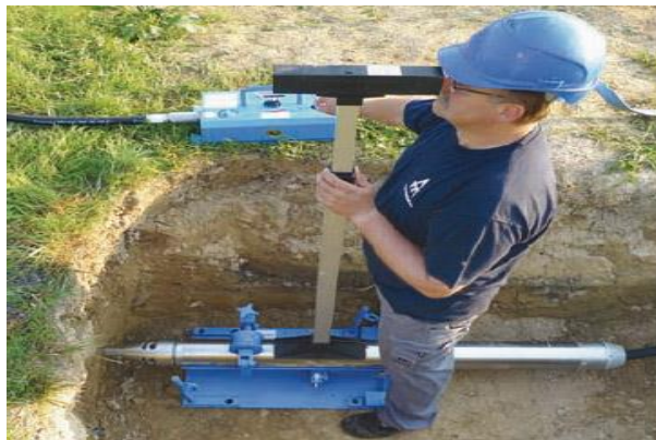
Figura 6. Acometida domiciliar con Topo
