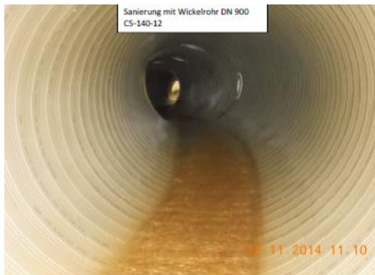
Tubería rehabilitada con SWP-SL tipo C5
