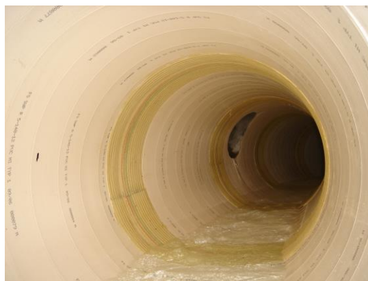
Instalación de tubería SWP tipo C con curva y acometida domiciliar
