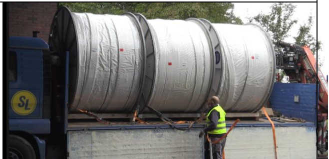
Descargando bobinas de perfil XL en sitio de obra
