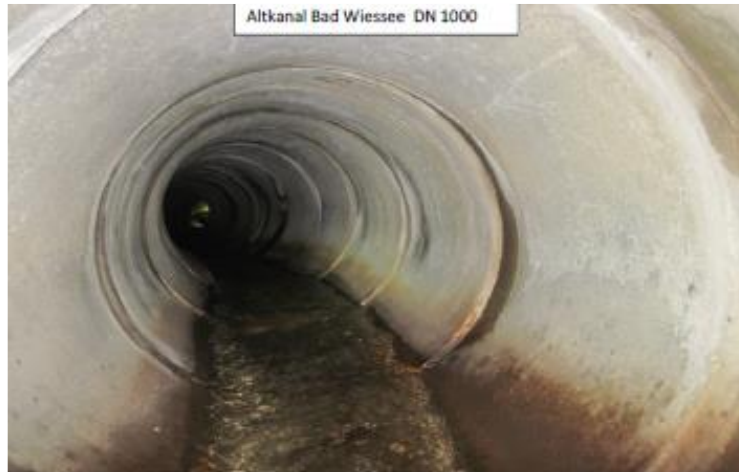
Tubería en trayectoria curva lista para rehabilitar
