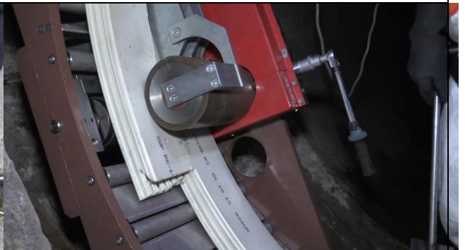
XL de 1.900mm en formación dentro de pozo
