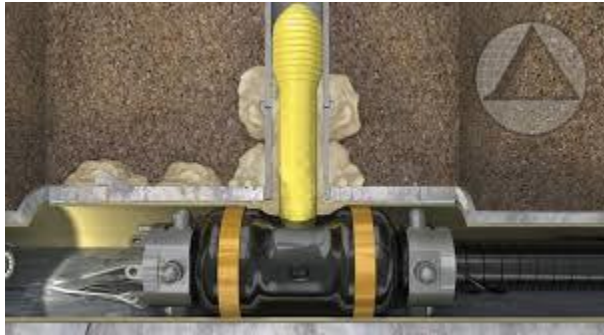
Sellado de acometida domiciliar y estabilización de suelo con AVANTI grout
