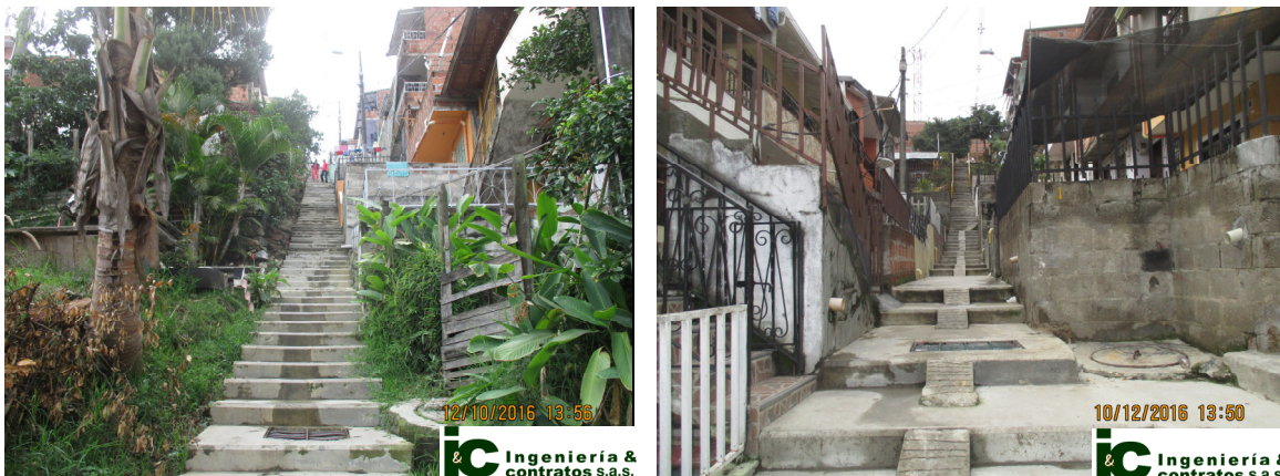
Figura 3. Fotografías de la zona de trabajo (calle 102C entre carreras 82F y 82FF). Obsérvese que el alcantarillado está construido por el costado derecho, bajo los antejardines.
