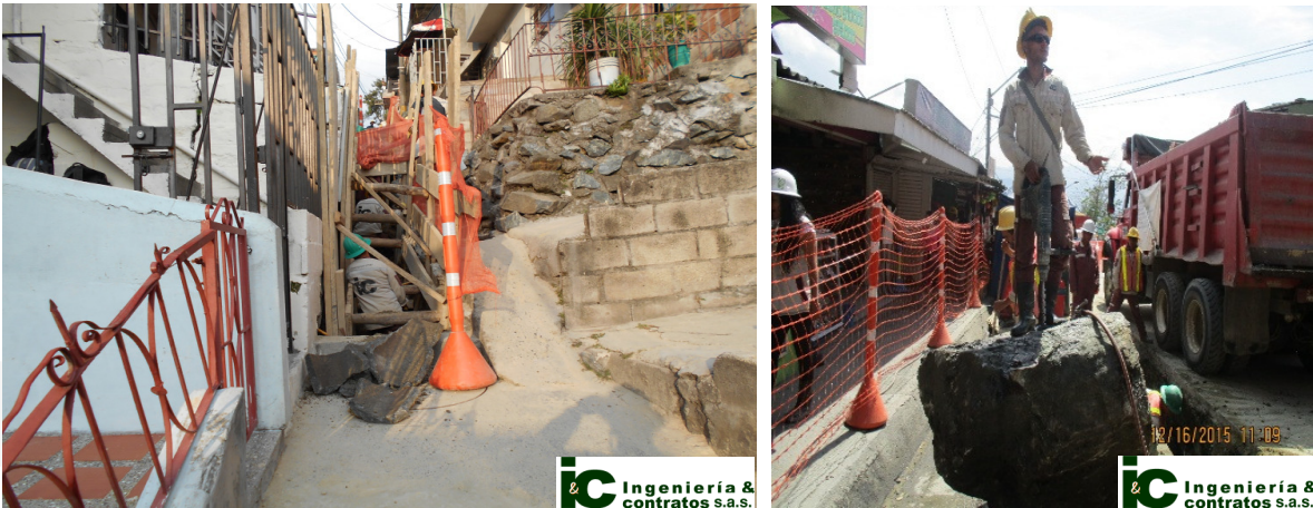
Figura 4. Excavaciones a zanja abierta en terreno rocoso y estrecho. Picacho, Grupo 2.
