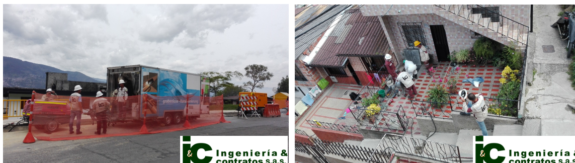
Figura 6. Izquierda: tráiler para impregnación y equipos auxiliares del CIPP de acometidas. Derecha: Fotografía tomada durante una rehabilitación de acometida domiciliar de 7m con CIPP.
