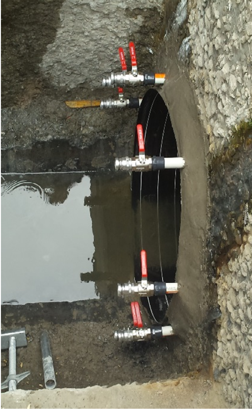
Figura 5: Conexión con cámara de acceso
