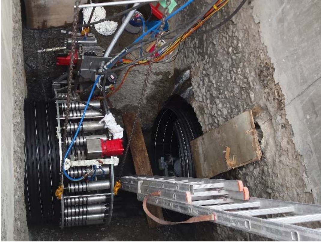
Figura 4: Máquina SEKISUI SPR-PE enrollando el perfil dentro de la tubería
