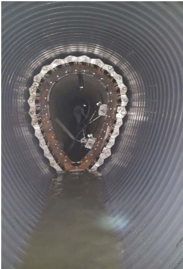
Figura 6: Máquina SEKISUI SPR™ enrollando perfil dentro de la tubería averiada
