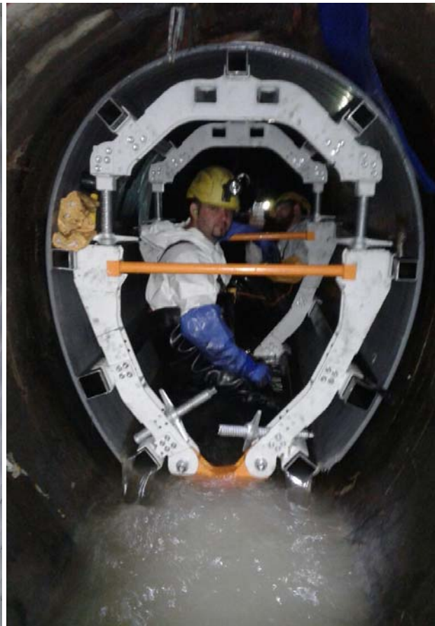
Figura 7: Colocación del apuntalamiento para la inyección
