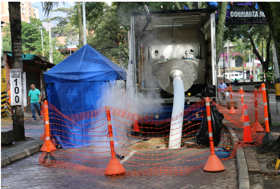
Figura 2. Tecnología CIPP para redes de alcantarillado
