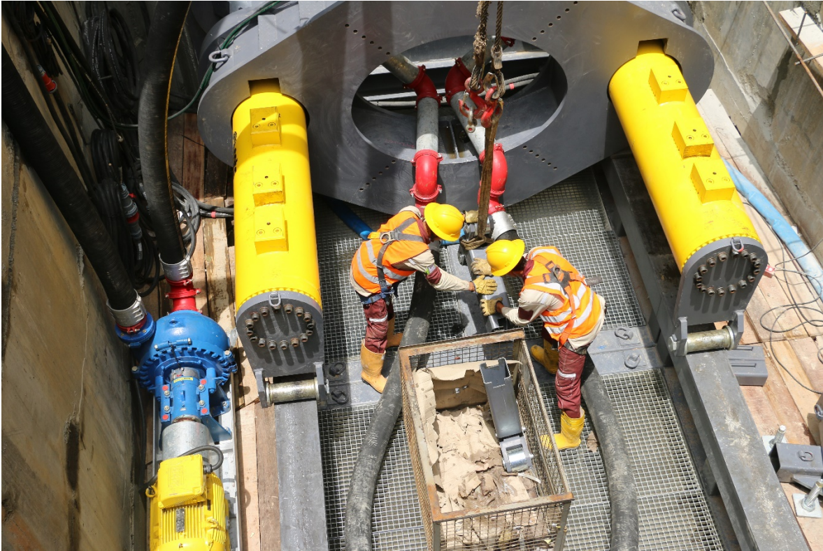
Figura 3. Tecnología Pipe Jacking para redes de alcantarillado
