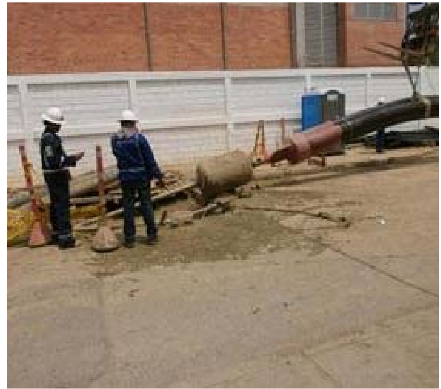
Perforación horizontal dirigida o tecnología sin zanja
