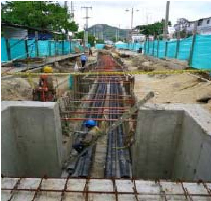
Excavación a cielo abierto
