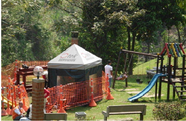
Figura 10: Trabajos en el parque infantil sin afectar su uso
