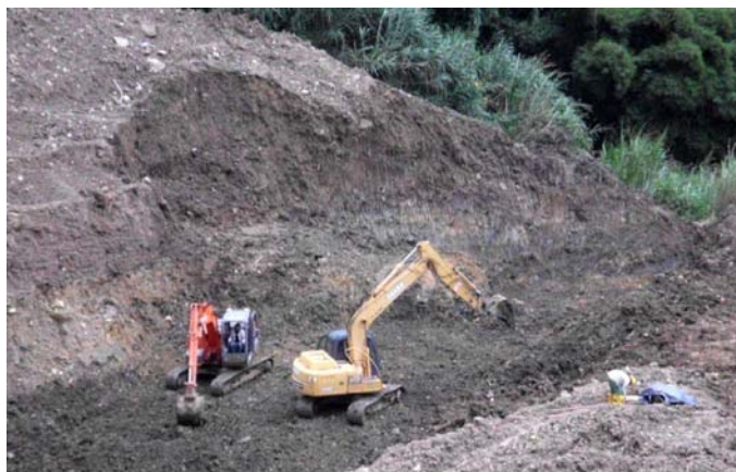
Figura 12: retroexcavadoras en búsqueda de cámara de inspección.
