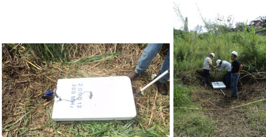
Figura 7: Aspectos del trabajo con geo radar
