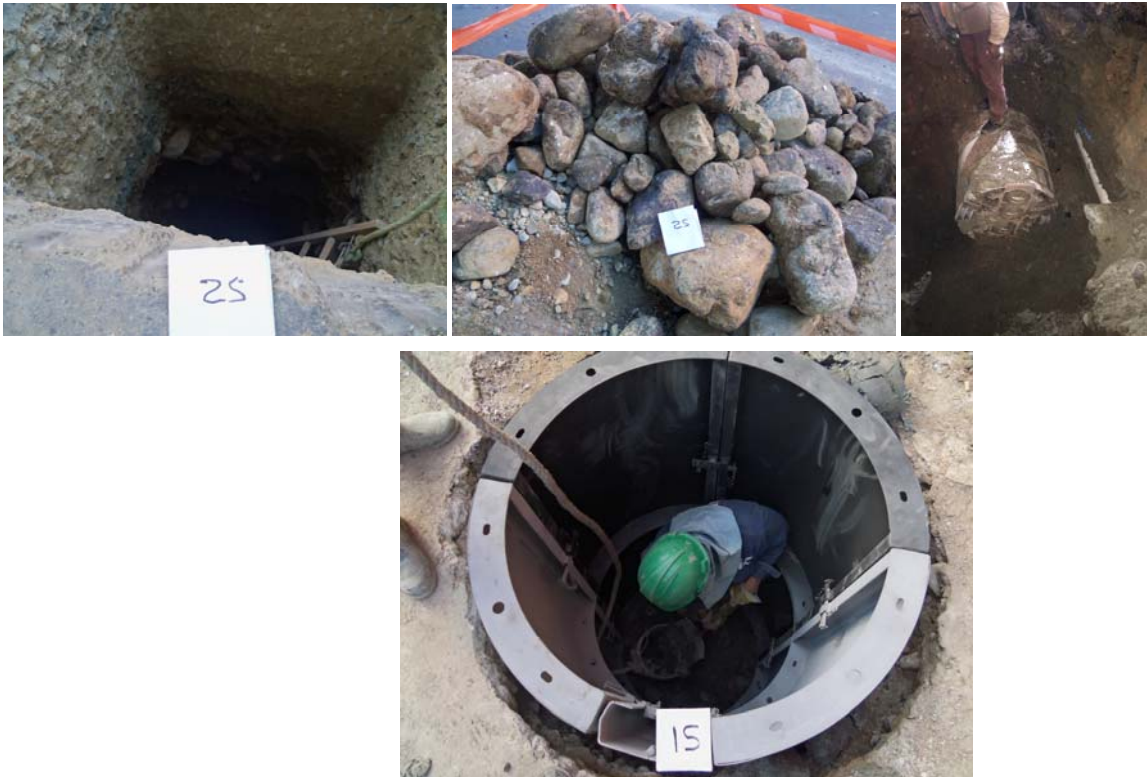
Figura 1- Investigación geotécnica para determinación de presencia de cantos y bolos
