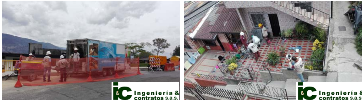
Figura 5. Izquierda: tráiler para impregnación y equipos auxiliares del CIPP de acometidas. Derecha: Fotografía tomada durante una rehabilitación de acometida domiciliar de 7m con CIPP.
