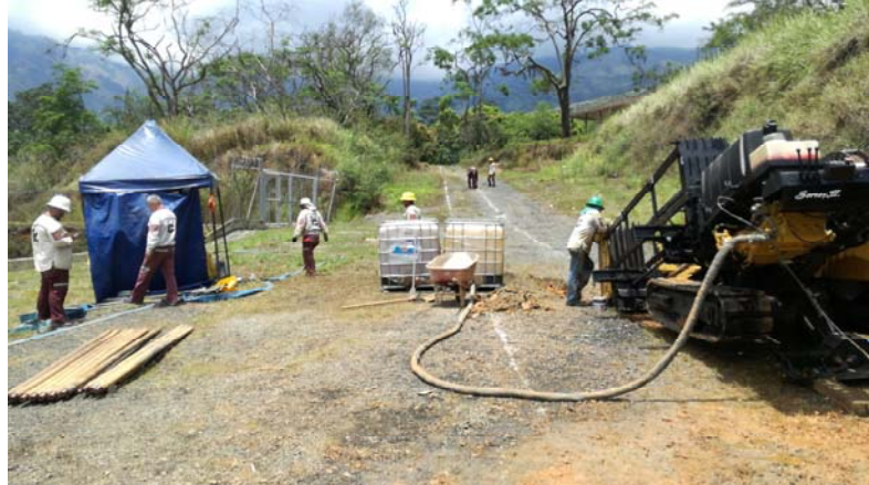
Figura 3 –Instalación de tubería con PHD
