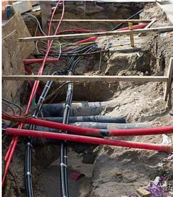
APERTURA DE ZANJAS
