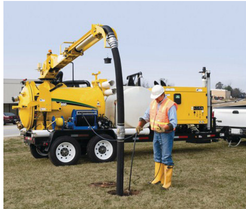
EXCAVACIÓN POR ASPIRACIÓN
