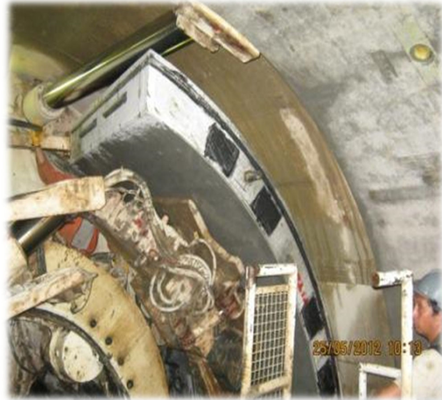
Instalación dovelas
