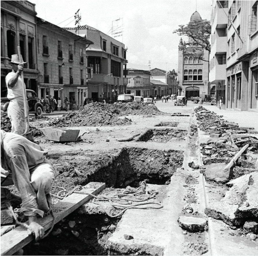
Construcción del alcantarillado en la carrera Junín en Medellín la segunda mitad de la década de 1940 – Quebrada Santa Elena
