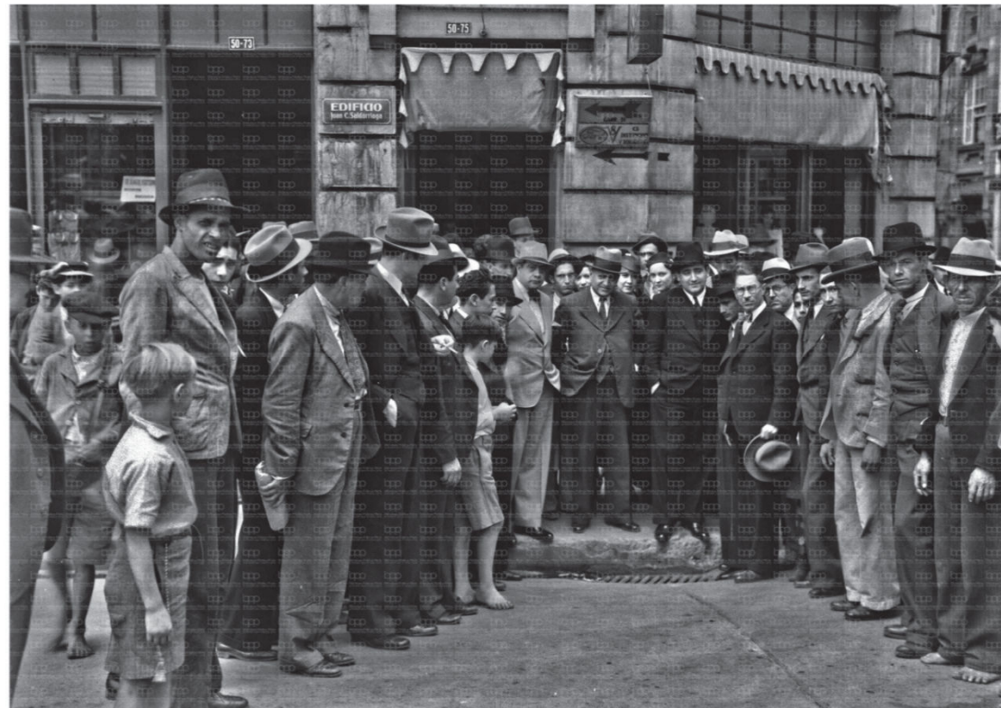
Instalación de alcantarillado 1936.
