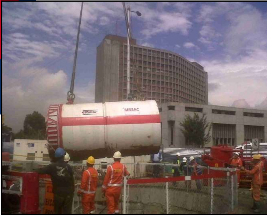
Deprimido Ampliación Calle 26 de Bogotá EPB1600. 871m
