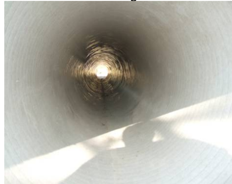
Tubería rehabilitada por slip lining
