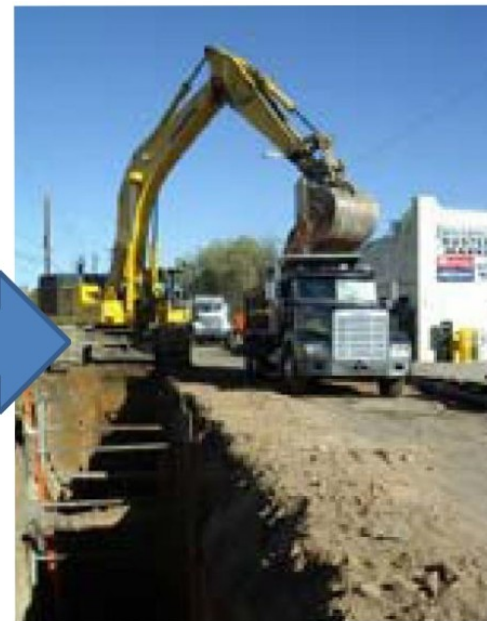
Obra con zanja abierta
